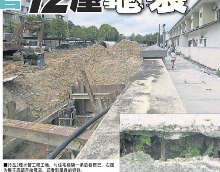
■冷岳2埋水管工程工地，与住宅相隔一条后巷而已。右图为屋子底部开始悬空，还看到屋身的钢铁。
